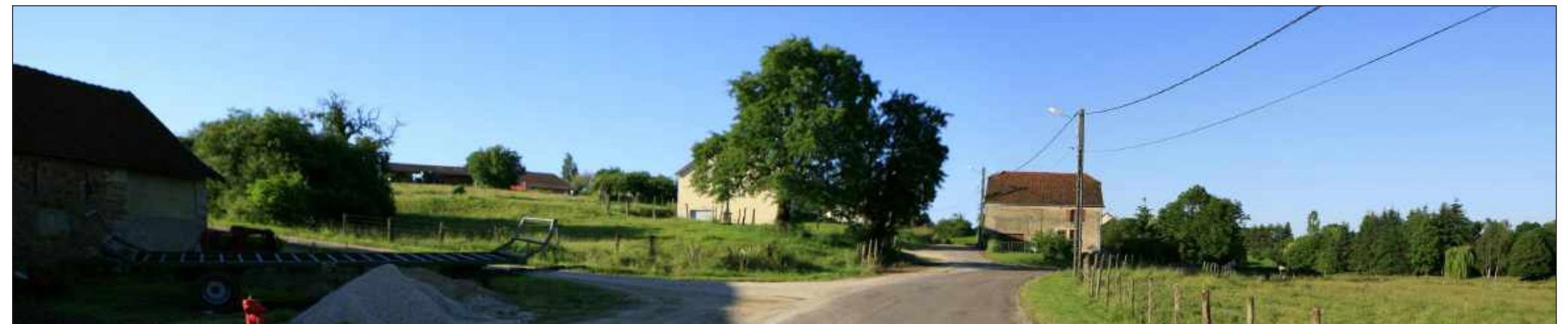
Vue du site avant projet
