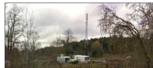
Antenne Télécom, à Montsaugéon
