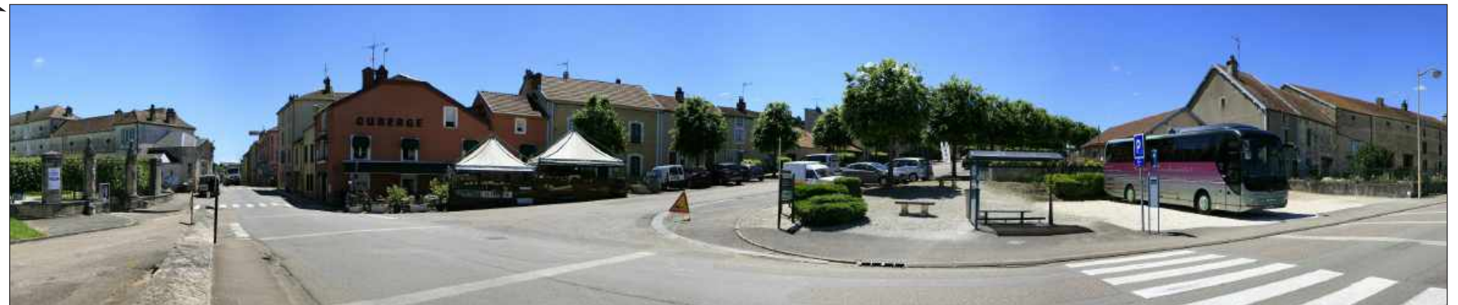
Vue du site avant projet
