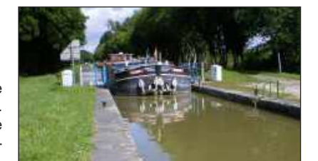
Péniche au passage d'une écluse
