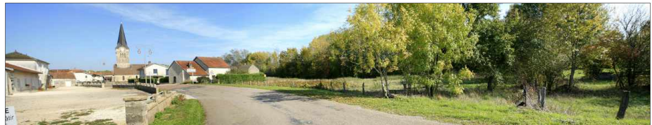
Vue du site avant projet
