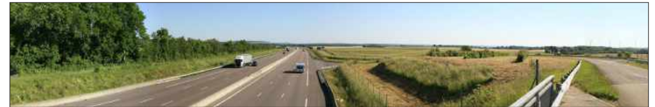
Vue de l'autoroute A31, au Sud-Ouest de Leuchey
