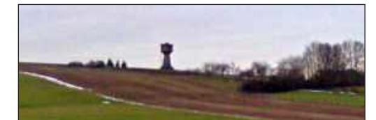
Château d'eau à colonne du Prélot
