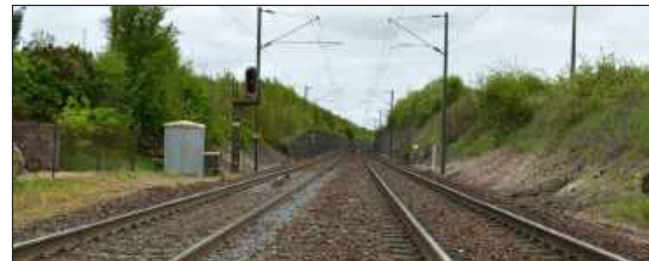
Vue de la voie ferrée, à Isômes
