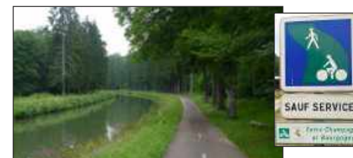
Vue de la Voie-verte le long du canal
