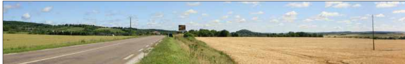
Vue de la RD974, au Sud de Vaux-sous-Aubigny
