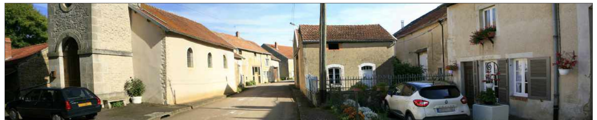
Vue du site avant projet
