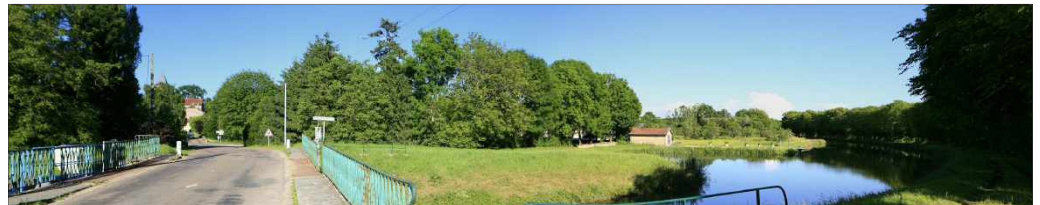
Vue du site avant projet
