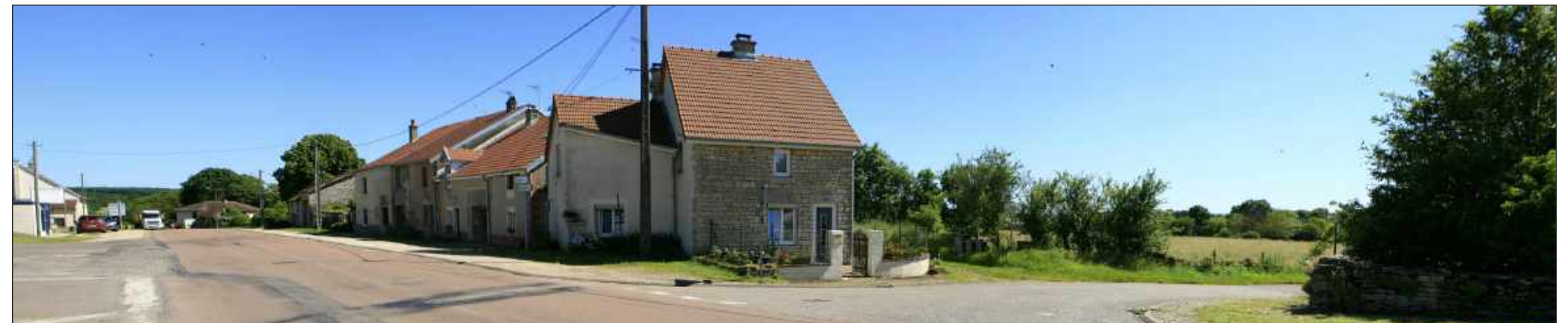
Vue du site avant projet
