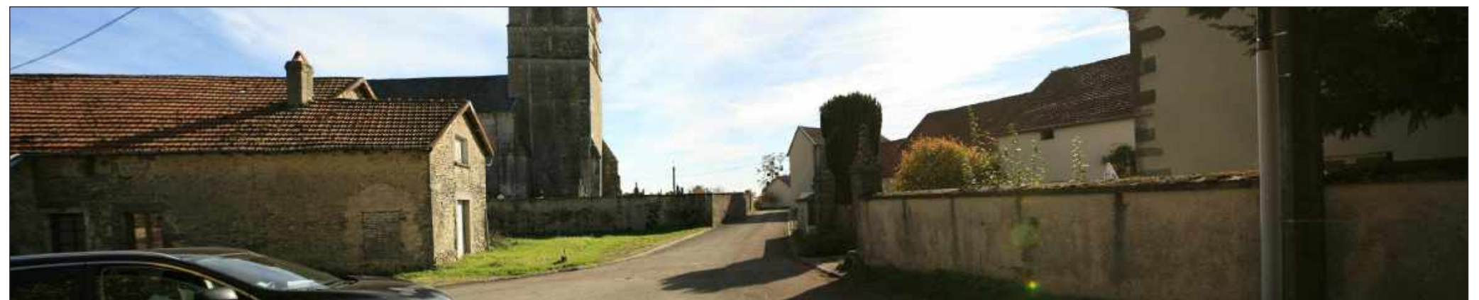
Vue du site avant projet
