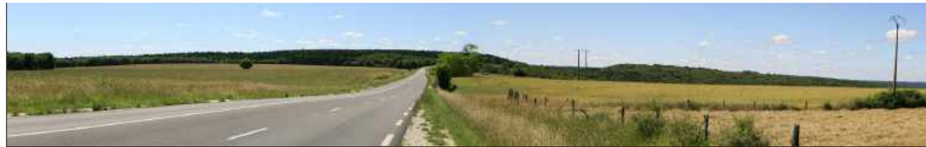
Vue de la RD67, au Nord-Ouest de Champlitte
