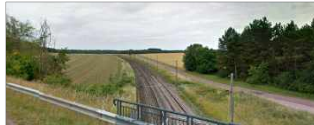
Vue de la voie ferrée, à Vaux-sous-Aubigny
