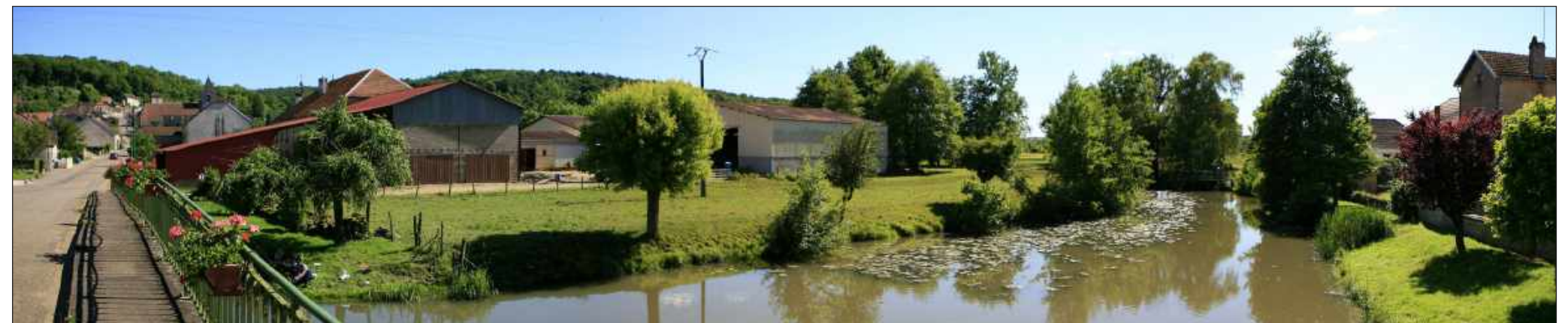
Vue du site avant projet
