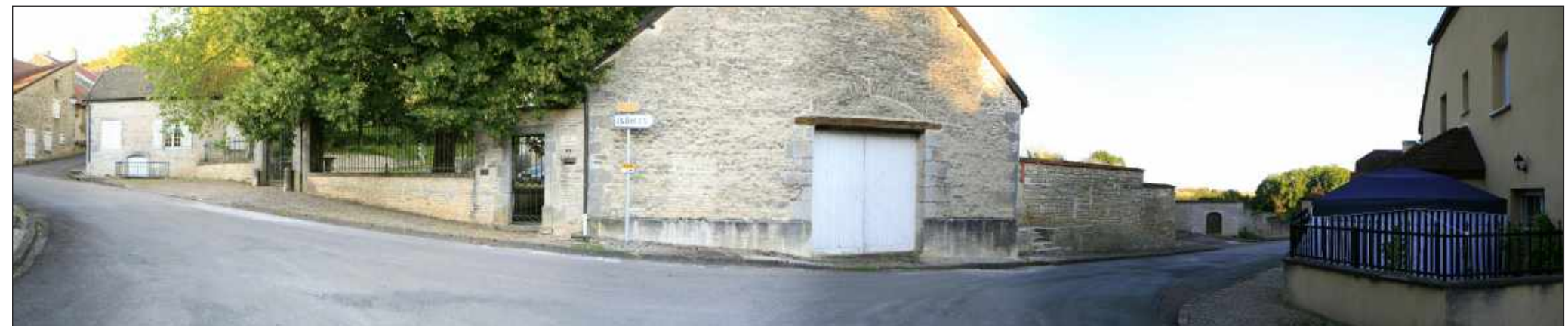
Vue du site avant projet
