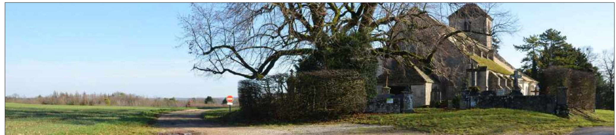
Vue du site avant projet
