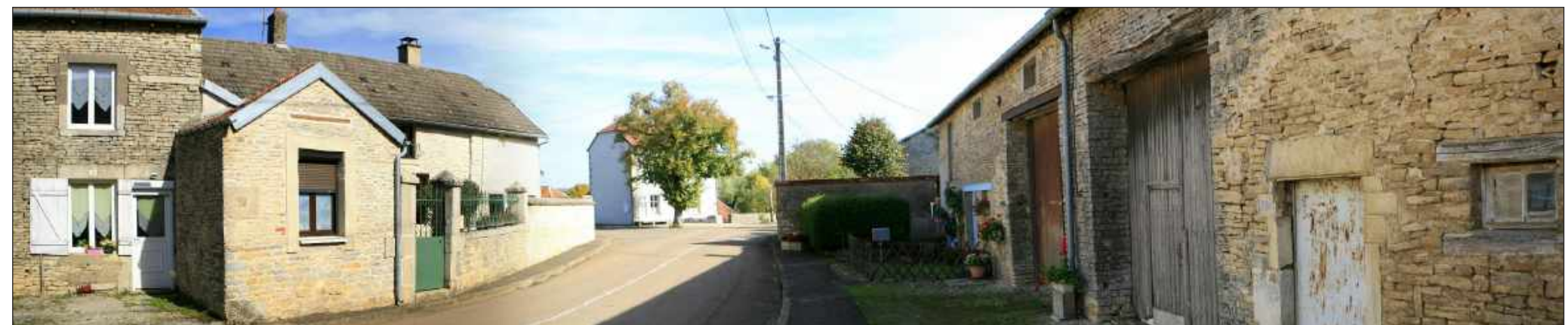
Vue du site avant projet
