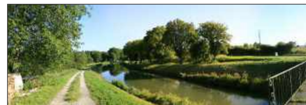
Vue des alignements le long du canal
