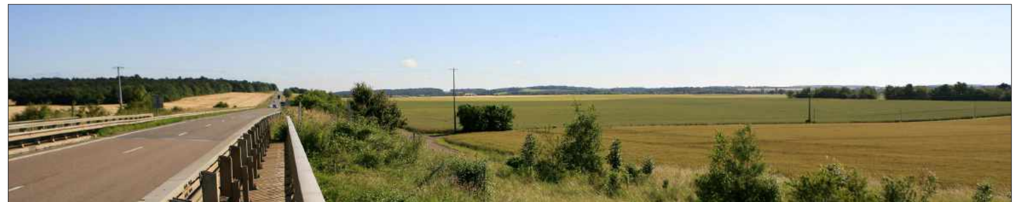
Vue du site avant projet
