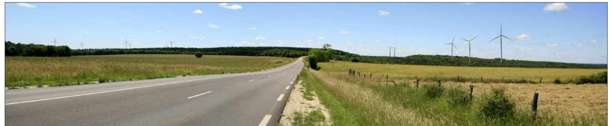
Vue du site avant projet
