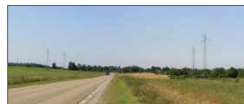
Ligne HT, au Nord du périmètre d'étude
