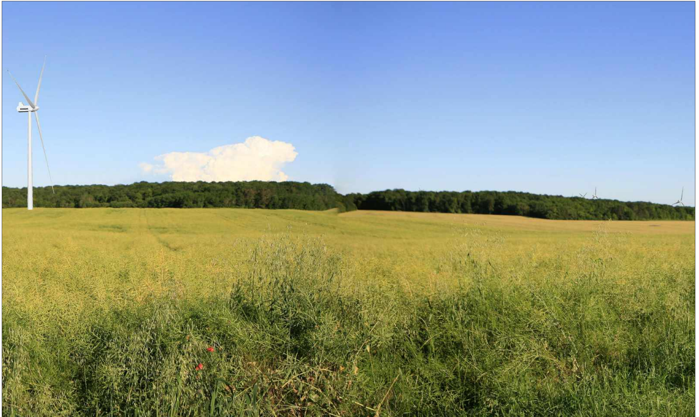
PHOTOMONTAGE DU PROJET EOLIEN EOLE DES CHARMES (angle de vue d'environ 60°, correspondant à la vision humaine et centré sur le projet)
