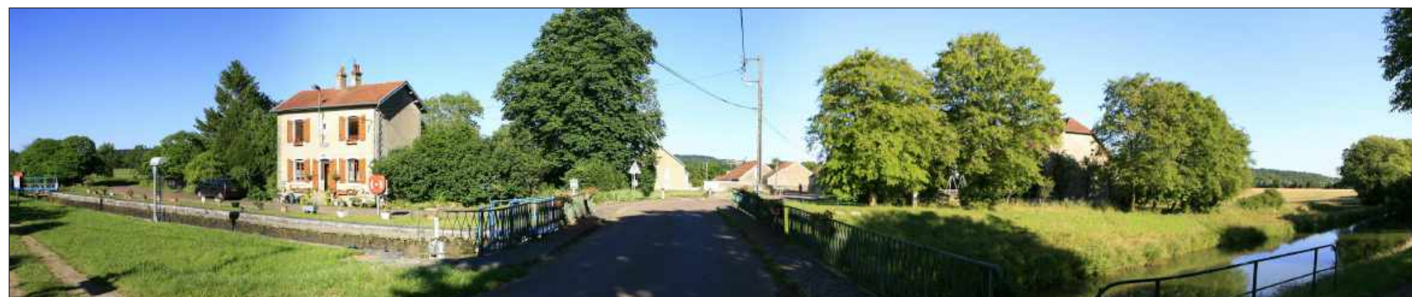
Vue du site avant projet
