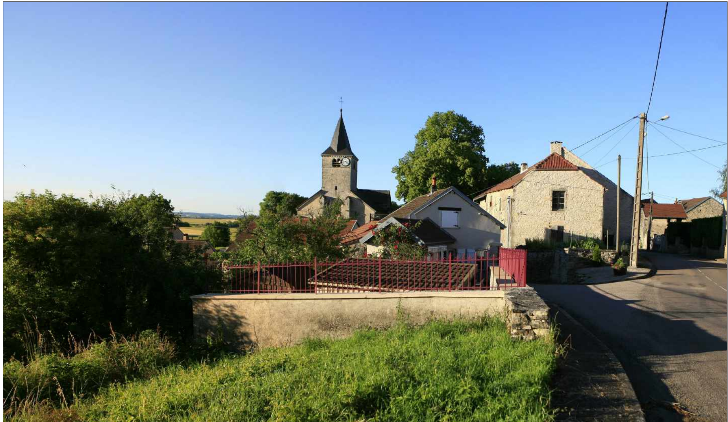
PHOTOMONTAGE DU PROJET EOLIEN EOLE DES CHARMES (angle de vue d'environ 60°, correspondant à la vision humaine et centré sur le projet)
