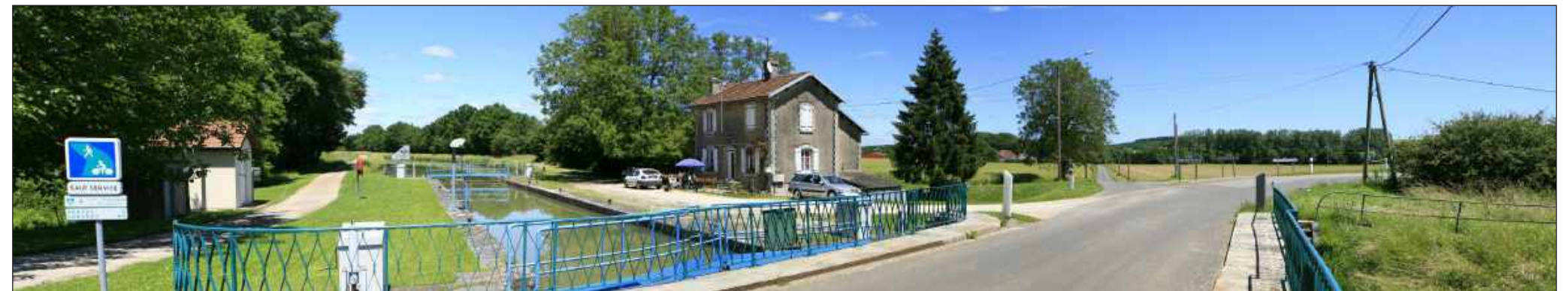
Vue du site avant projet
