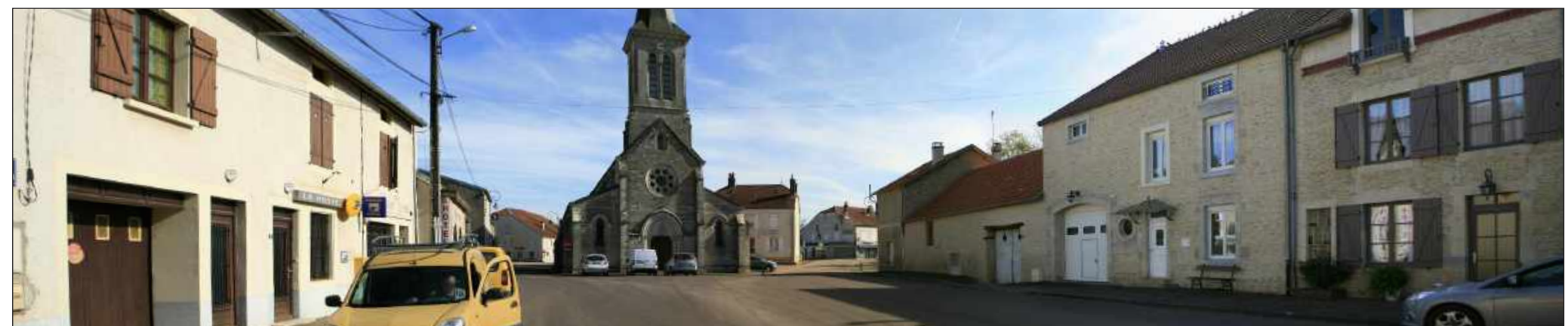
Vue du site avant projet
